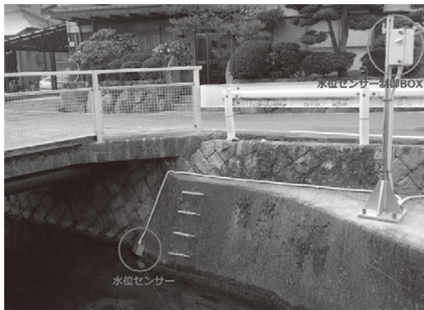
写真1 水位センサー設置イメージ
