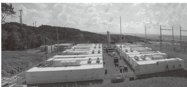
写真 1 PJM 周波数調整市場向け 32MW GSS (米国ウェストバージニア州)
