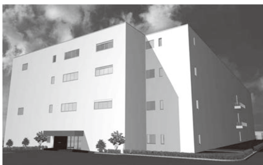
図1 NEC神奈川データセンター
