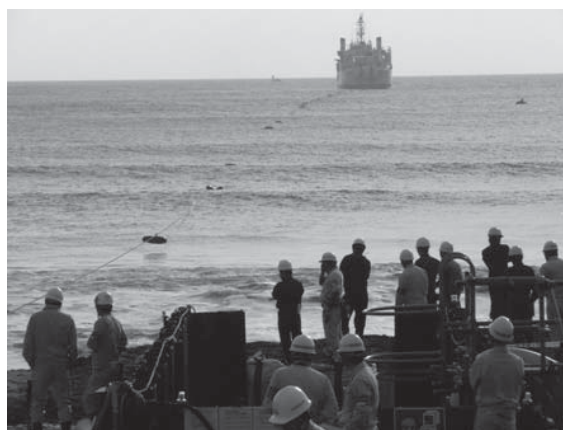
写真2 陸揚げの作業風景
