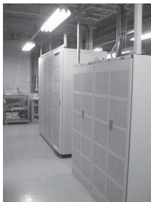
写真3 端局装置 (気象庁)
