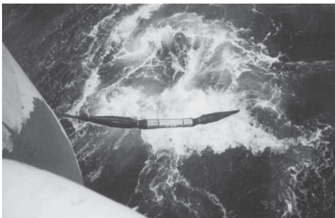
写真3 太平洋に敷設されるケーブルと中継器
