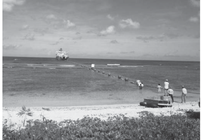
写真2 ケーブル陸揚げ風景
