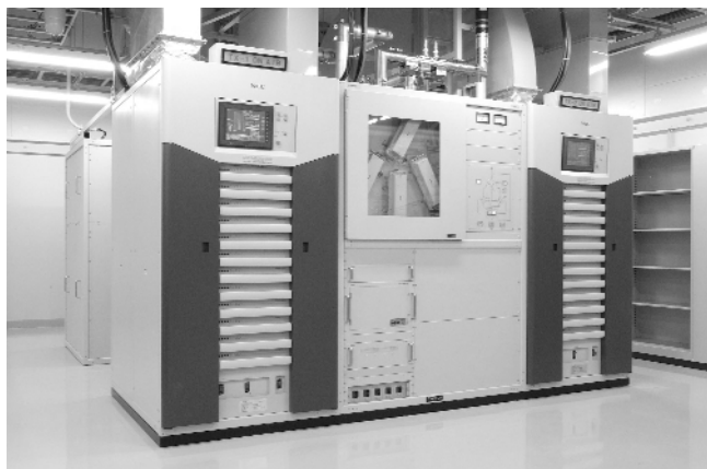
写真2 UHF デジタルテレビ送信機および出力同軸装置の外観 Photo 2 UHF digital television transmitter.
