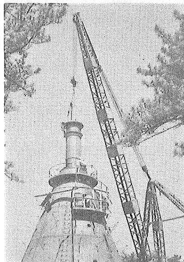
第7図 方位主軸の組込作業
