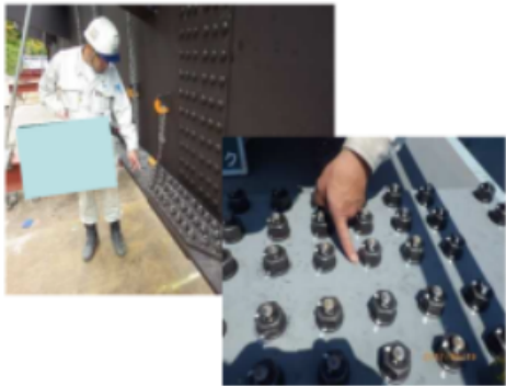
締め付け全数確認・塗装膜厚確認 (イメージ)
