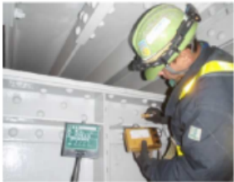
締め付け全数確認・塗装膜厚確認 (イメージ)
