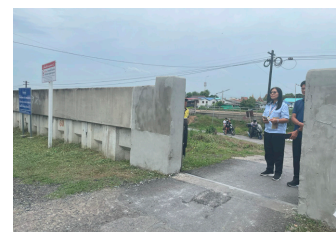
工業団地での洪水対策(止水板設置箇所と排水ポンプ)
