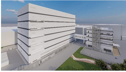
図 22：NEC 神奈川データセンター二期棟
