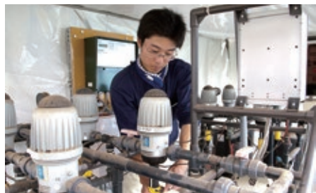
※給水用タンクなどの給水システムに設けた弁、バルブの開閉によって水の流量をコントロールし、作物に対する供給分量を調整する。
