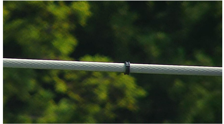
実証実験時にドローンが撮影した電線 (※) (直径 18.2 mm)
