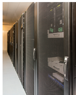
琉球大学病院のサーバ室。仮想基盤上に病院情報システムを搭載、ランサムウェア対策として統合バックアップシステムを準備している他、サーバラックにはUPSやサーバ冷却システムを設置し、BCP・省エネルギー対策も施している。
