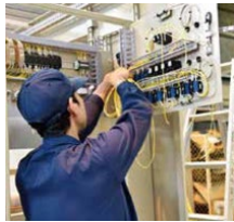
写真：作業の様子
