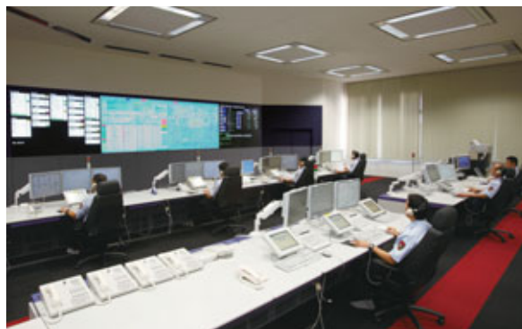
消防指令センター
