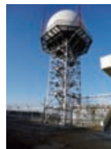
航空管制レーダー
