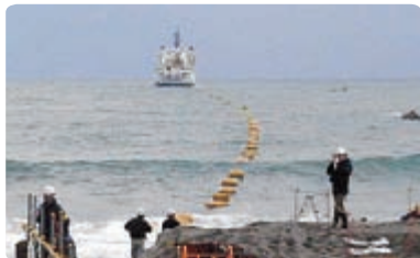
海底ケーブルの敷設
