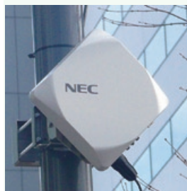
屋外一体型超小型マイクロ波通信システム「iPASOLINK AOR (All Outdoor Radio)」
