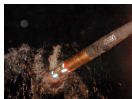
海底地震計敷設の様子
