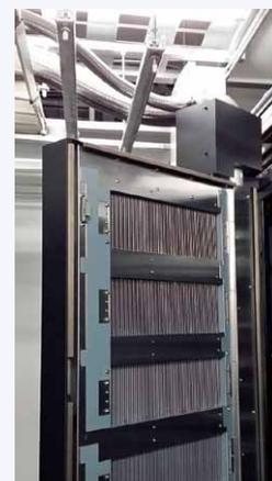
相変化冷却技術に基づく冷却装置
