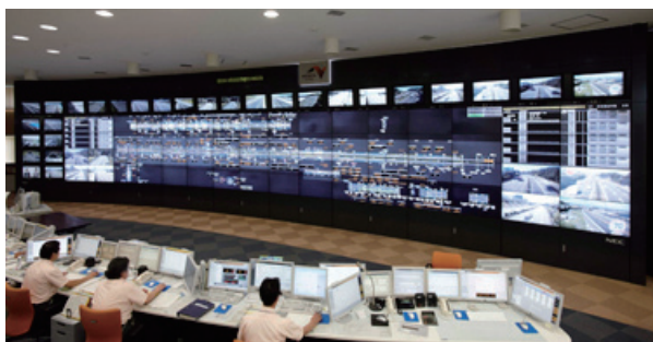
道路管制センターの大型表示装置
