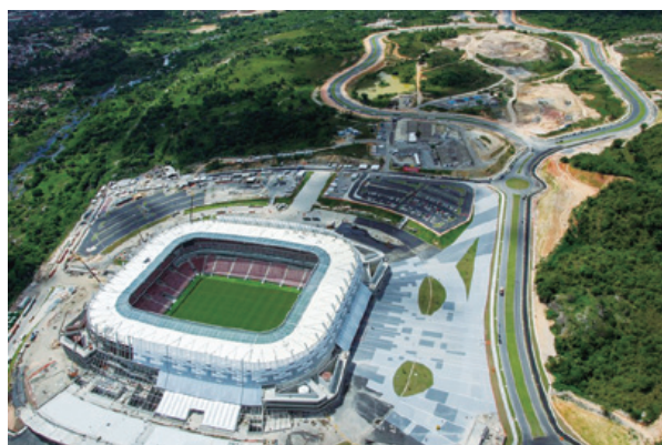
建設中のペルナンブコスタジアム
