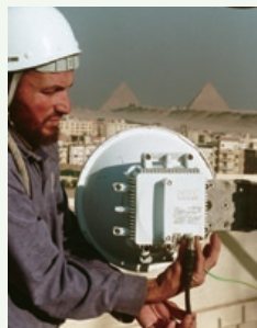
超小型マイクロ波通信システム 「パソリンク」
