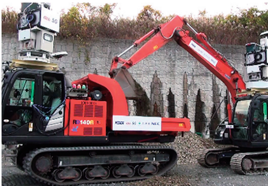
5Gを活用した建設機械の遠隔操作
