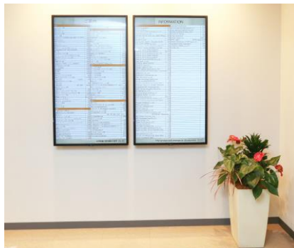
地下管理室前
