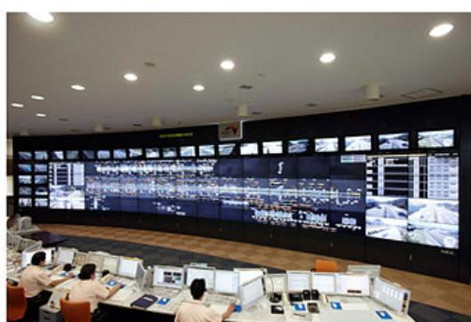
道路管制センターの大型表示装置
