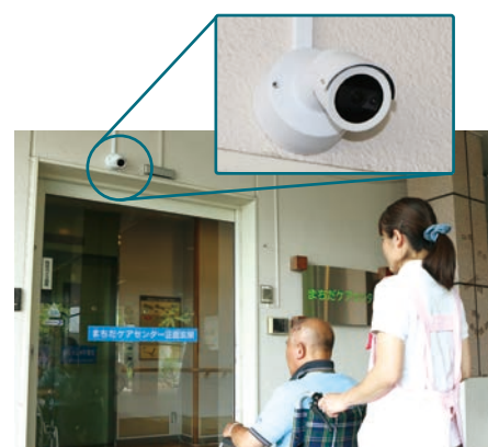
車いすを押す職員がカメラに顔を向けるだけで瞬時に自動ドアが開くようになり、スムーズで安全な入退館が可能に
