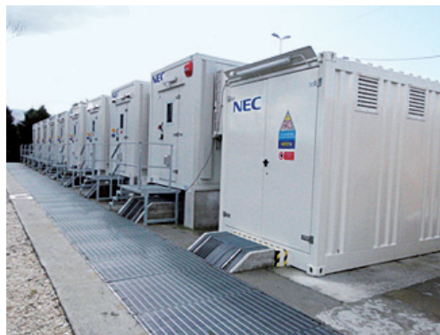
エネル・ディストリビューゾーネ社に納入した 大容量リチウムイオン蓄電システム
