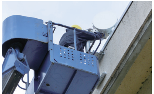
小学校の校舎へのネットワーク機器の据付け工事
